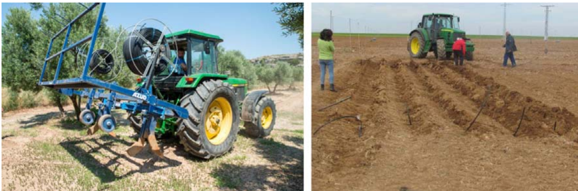
Figura 1: Instalación de riego localizado subterráneo.
