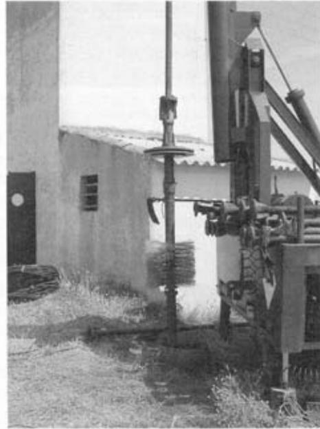
Fig. 10.31. Equipo combinado para cepillado y pistoneo de sondeos (foto J. Martínez).
