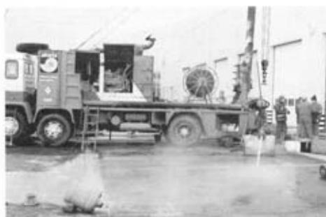
Fig. 10.35. Bombeo de un sondeo tras su regeneración química, con neutralización de sus vertidos (foto J. Martínez).
