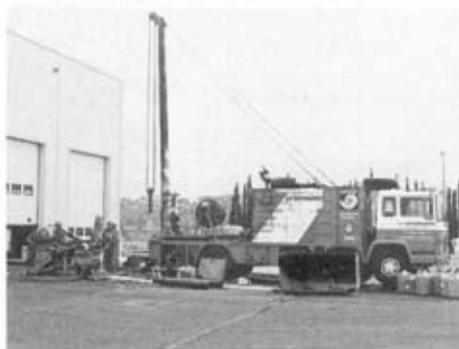
Fig. 10.33. Regeneración de sondeos mediante inyección y bombeo filtro a filtro, empleando un dispositivo de doble packer (foto J. Martínez).
